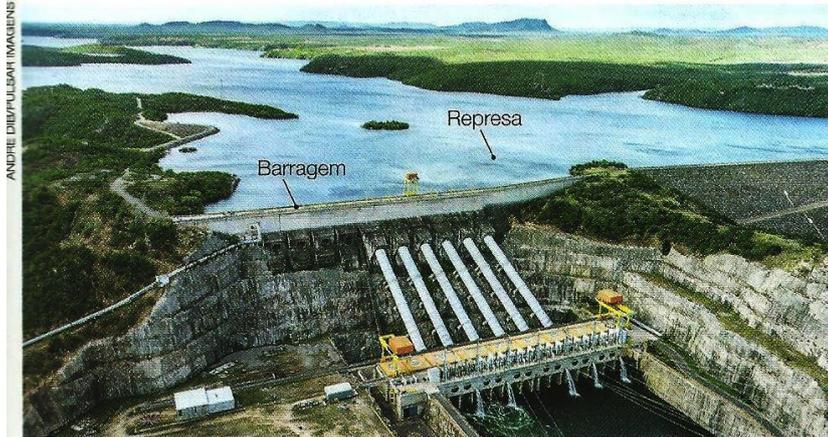
Nas usinas hidrelétricas, a água movimenta turbinas que geram energia elétrica. Vista aérea da Usina Hidrelétrica de Xingó e da barragem, que represa água do Rio São Francisco no município de Piranhas, Alagoas, 2016.
